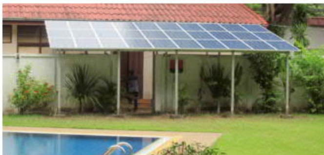
Stromversorgung bei Netzausfall
