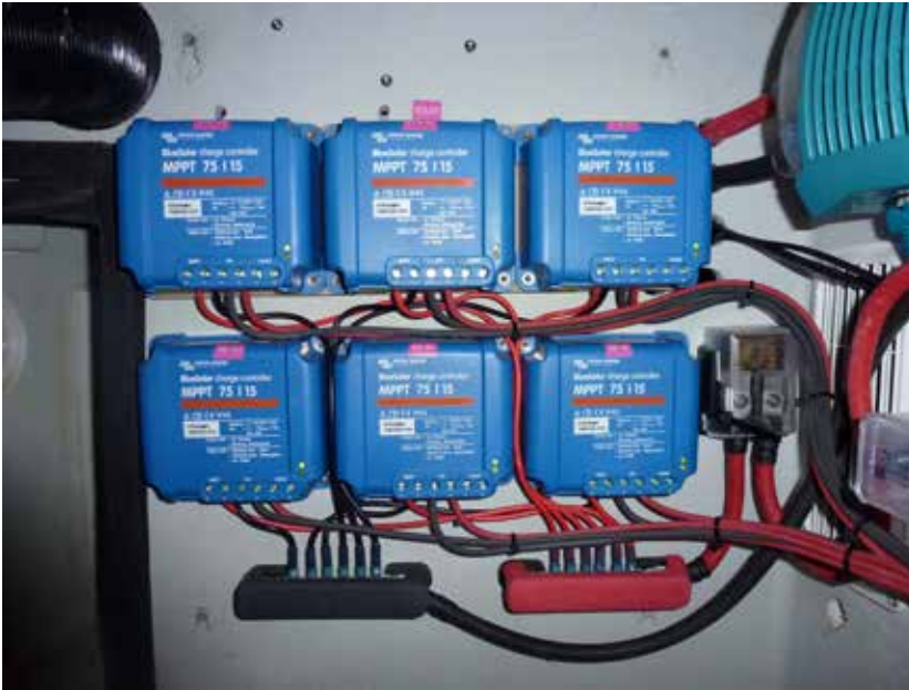
Für Leistungshungrige: Zur Erzielung der maximal möglichen Ausbeute bekommt jedes Panel einen eigenen MPPT-Regler.
