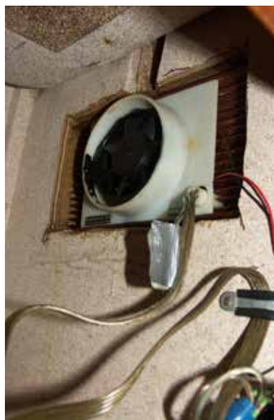
Kälte erzeugen produziert Wärme, die abgeleitet werden muss.
